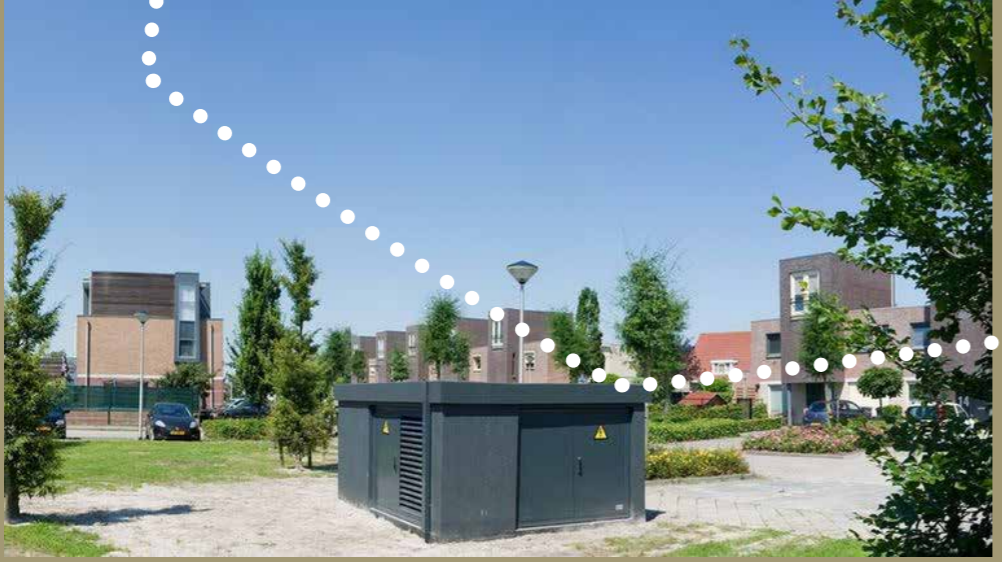
de behuizing van een buurtbatterij
