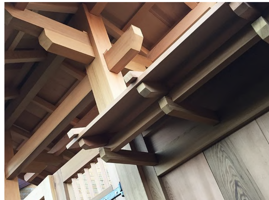
Nieuwe situatie met homogene houtverbindingen
