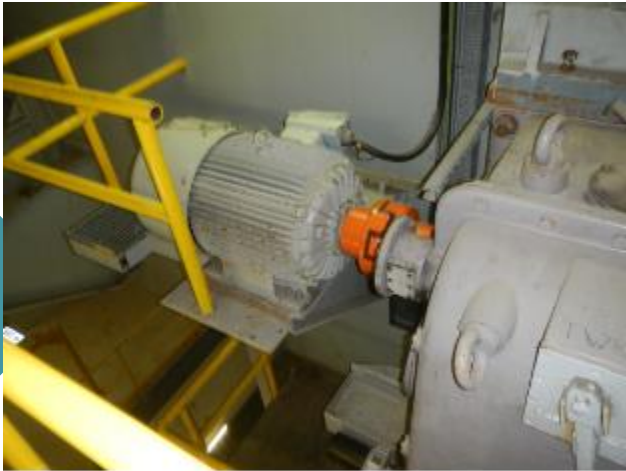
AANDRIJVING BASCULEBRUG
