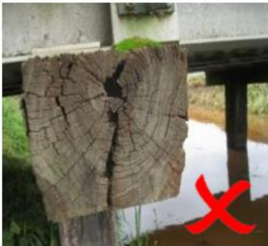
Figuur 4.10 Kopsekanten liggers: Links : aantasting door vochtintredeing kopse kant kesp (CUR 117); Midden : recht afgezaagde kesp; Rechts : naar binnen afgeschuinde kesp
