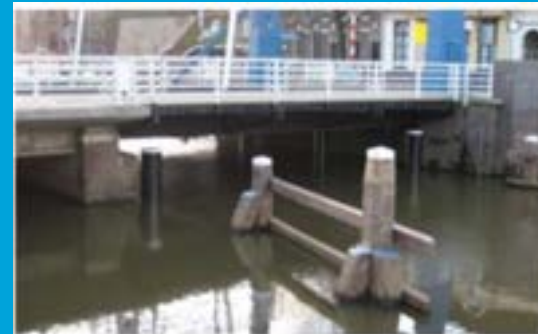
Remmingwerk met gebruikte basralocus palen
