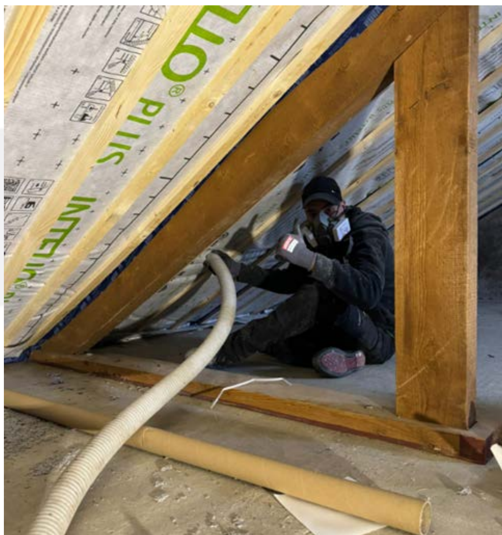
Inblazen cellulose renovatie met Duits
