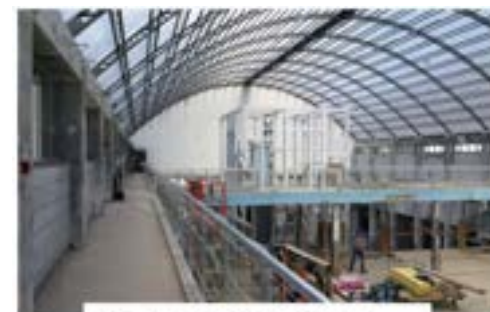
VERBOUWING MELKHAL IN ENSCHEDE: FINISH NADERT
