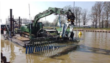
Waterschap Vechtstromen: Waterloop Elsmorsweg Oldenzaal
